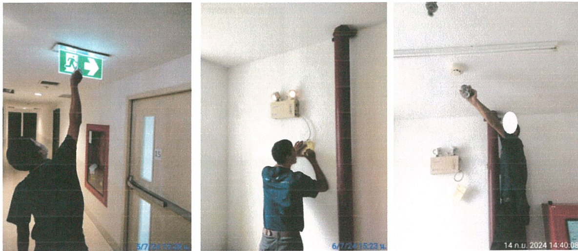
รูปภาพที่ 2.18 การตรวจสอบอุปกรณ์แจ้งเตือนและป้องกันอัคคีภัย
