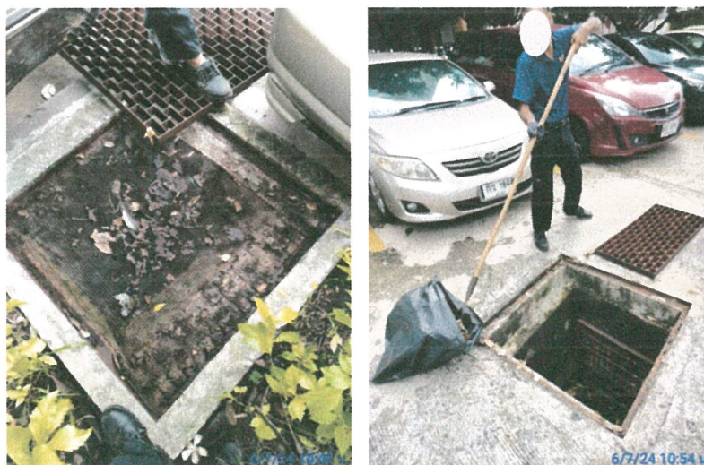
รูปภาพที่ 2.30 การขุดลอกตะกอน
