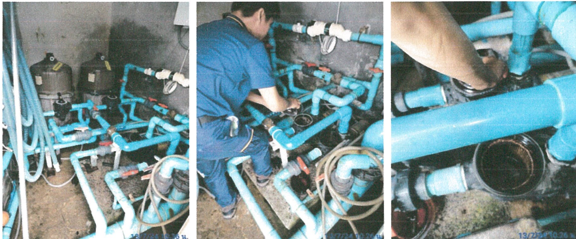
รูปภาพที่ 2.29 การตรวจสอบระบบการแจกจ่ายน้ำ และเส้นท่อ
