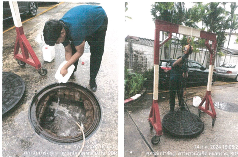
รูปภาพที่ 2.31 การเติมเชื้อจุลินทรีย์ระบบบำบัดน้ำเสีย
